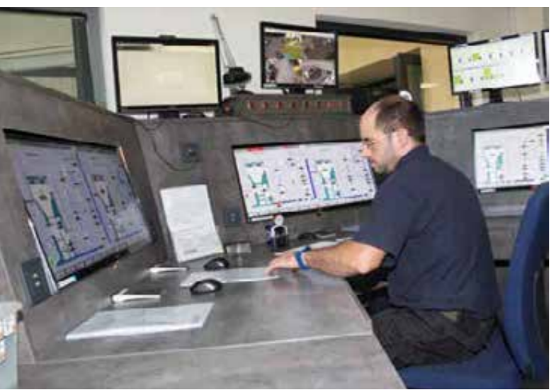
Auch die technische Überwachung der Einäscherung vom Steuerstand aus gehört zu Sascha Freinsbergs Aufgaben.
